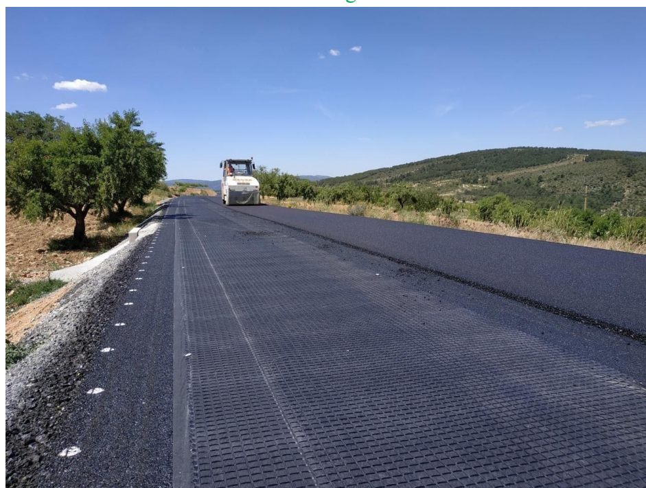
Joonis 36: Korrektelt laotatud geosünteed. 10
