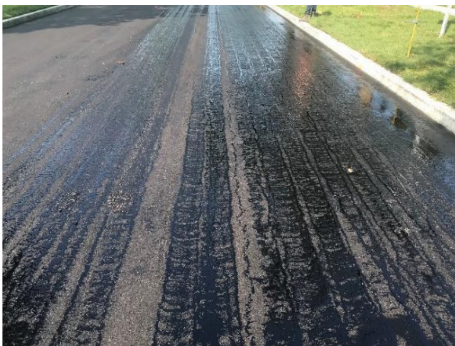
Joonis 33: Ebapiisav kogus bituumenit 7
