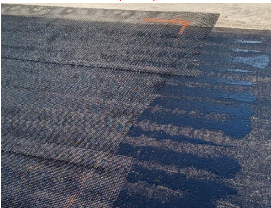
Joonis 34: Ebapiisav kogus bituumenit 8
