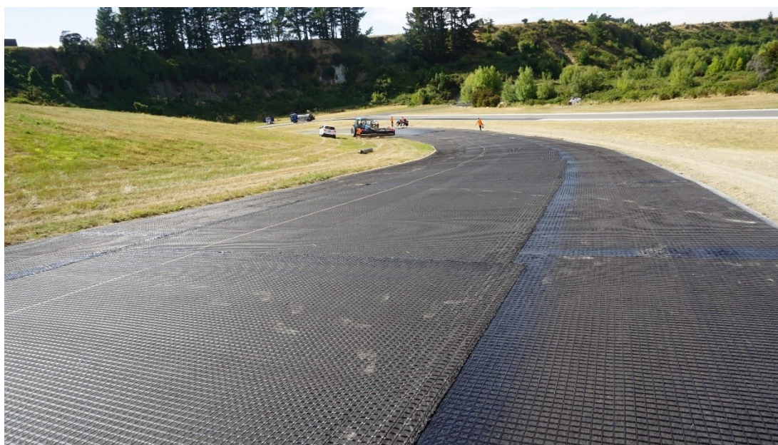
Joonis 37: Korrektselt laotatud geosünteed. 11
