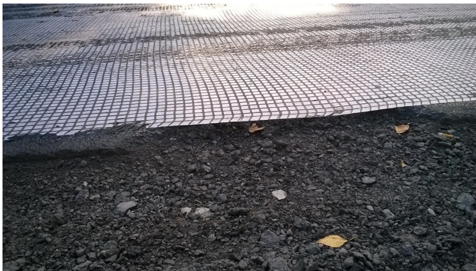
Joonis 29: Asfaldi geokomposiit on paigaldatud ebakorrektse aluspinna peale. Serv on jäänud alt tühjaks.
