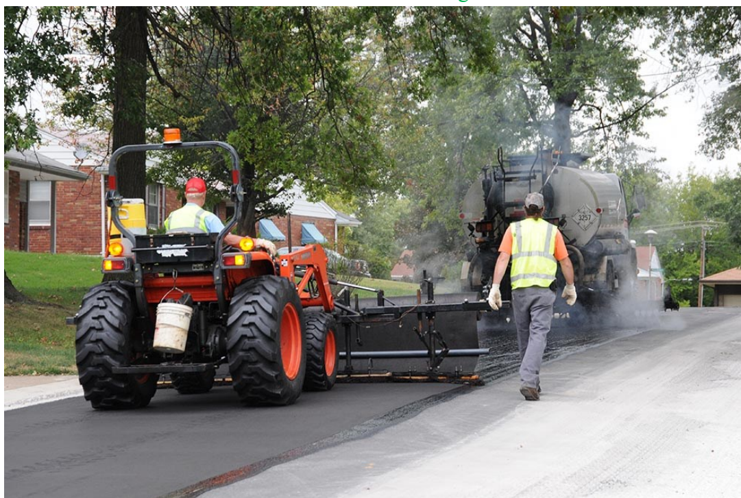
Joonis 38: Korrektnen geosünteedi paigaldus. 12
