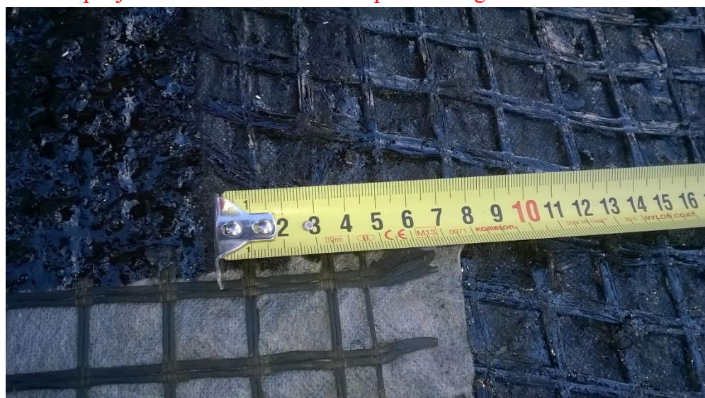
Joonis 32: Ebapiisav ülekate. Järgida tuleb paigaldusnõudeid.
